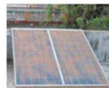
شکل ۴- تجمع گردوغبار بر روی پنل خورشیدی
